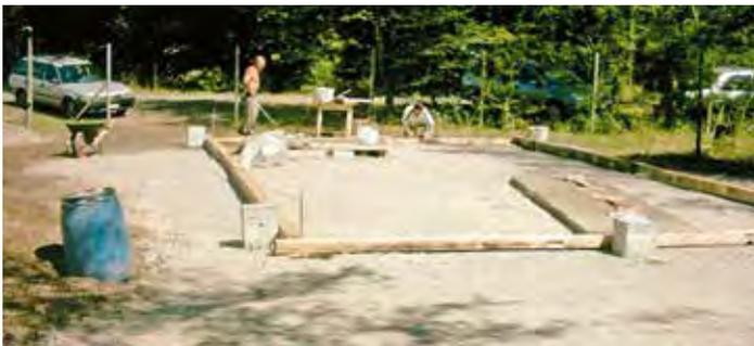
Jakob Frei und Fritz Keller betonieren 18 Fundamentsockel.
