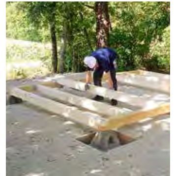
Das Fundament wird erstellt.
