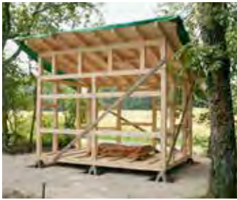
Der Rohbau steht.
