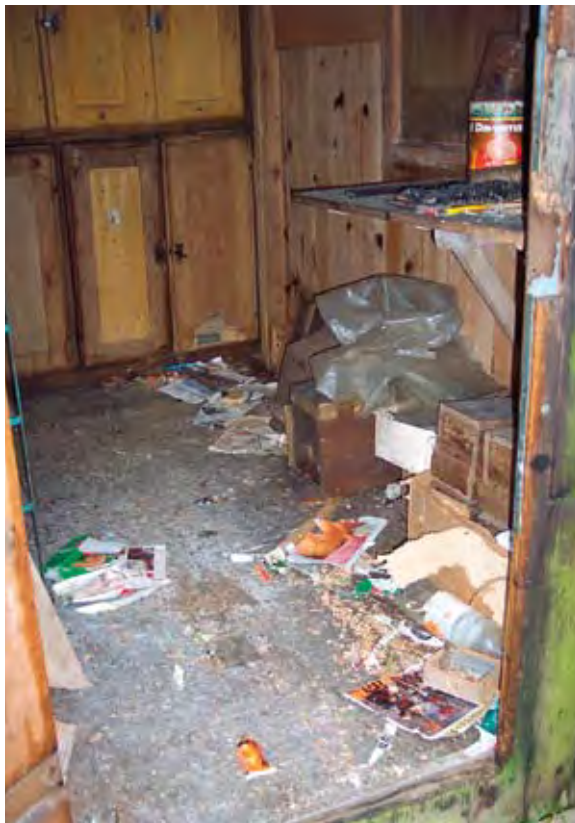
Es wird Zeit, dass die Untermieter umziehen.
