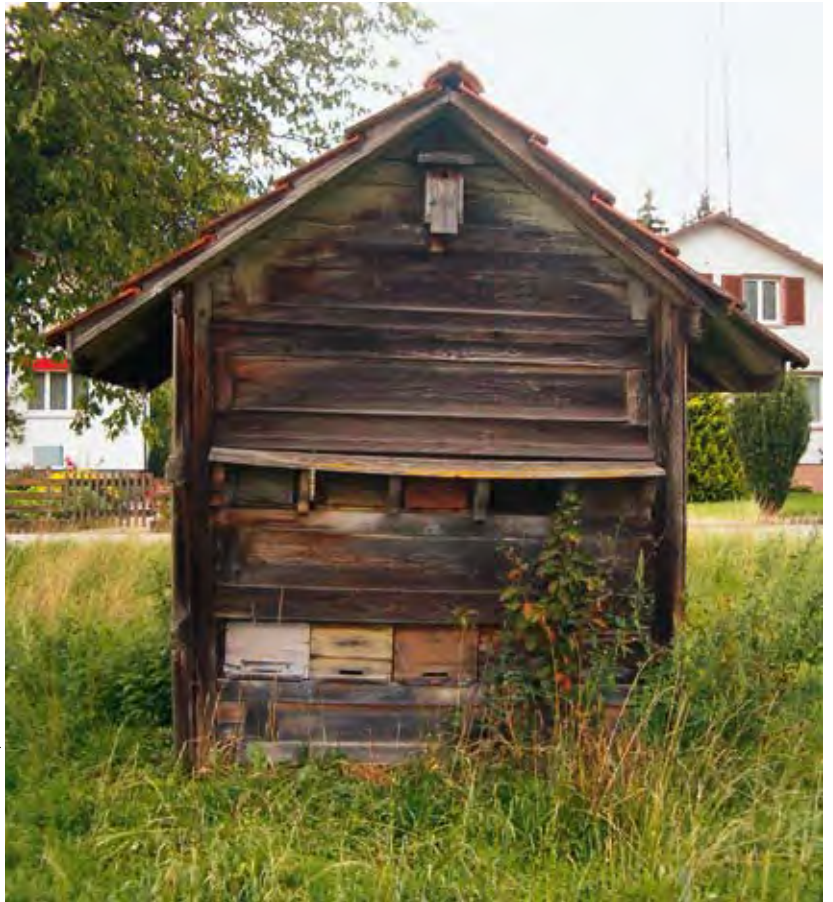
Verlottert und verfault, ein scheinbar hoffnungsloser Fall.
