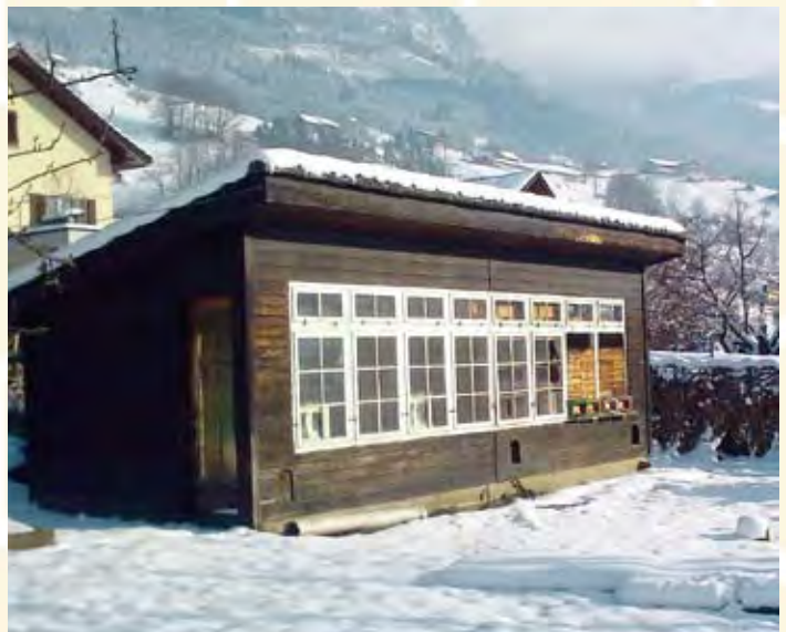
Dieses alte Hühnerhaus diente als erstes Bienenhaus. Es wird im kommenden Jahr wieder renoviert. Die Fenster sind schon bestellt.
