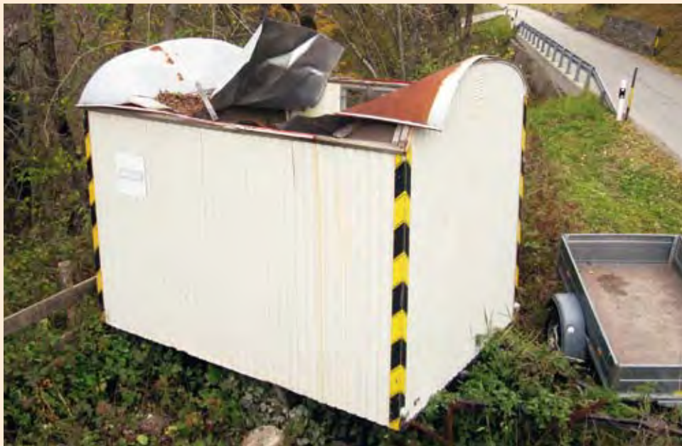
Zuviel Schneedruck auf dem Dach hat den Wanderwagen beschädigt.
