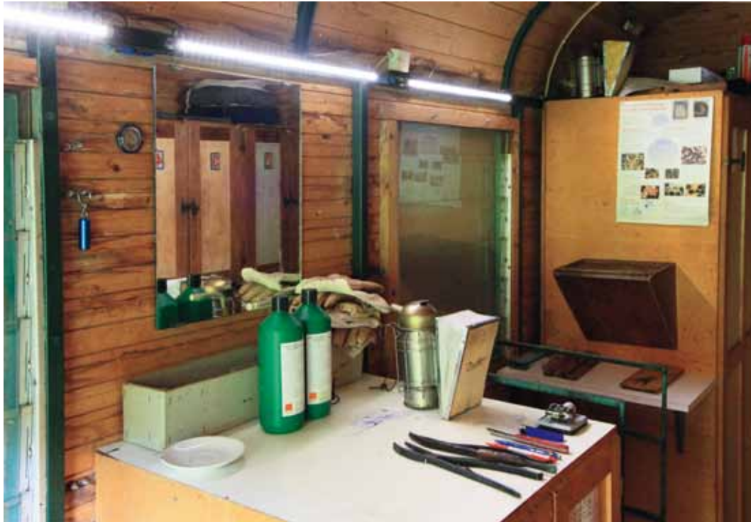
Die LED-Leuchten werden knapp oberhalb der Fenster eingebaut.
