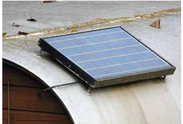
Die etwas höheren Ausgaben für einen Metallrahmen und gehärtetes Spezialglas garantieren eine viel längere Lebensdauer der Solarzellen.
