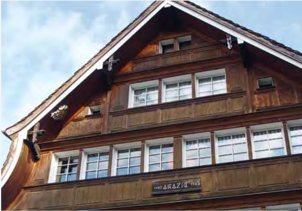
Unter dem linken Vordach dieses Hauses hat sich ein Bienenschwarm eingenistet und mit dem Wabenbau begonnen.
