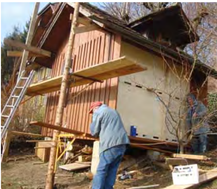
Bereits sind drei Seiten des Hauses bemalt, die vormaligen Verbindungs-latten angebracht und die Flugfront montiert.
