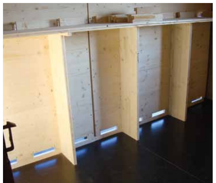
Innen wurde eine Fahrzeugplatte über den alten Boden montiert. Mit dem Gestell an der Flugfront wurde Platz geschaffen für 16 Mini Plus Völker.
