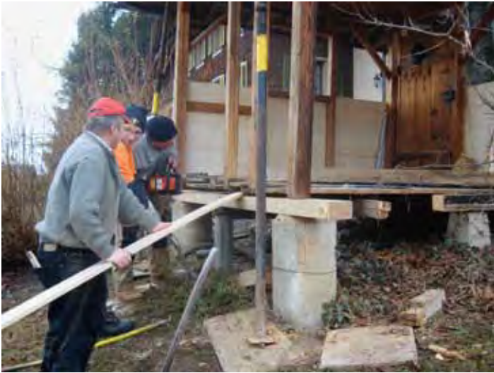
Die verfaulten Trägerbalken werden ersetzt ...
