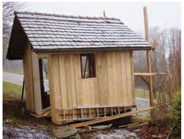
Dann werden die Tannenholz-Bretter darüber montiert. Damit das Bienenhaus seinen ursprünglichen Charakter behält, werden wie früher Holzlatten bei den Spalten angebracht.
