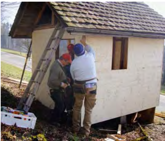
... bis unters Dach gesichert.
