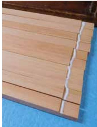
Bild 2: Auf die Trägerleisten wird etwas Holzleim gegeben.
