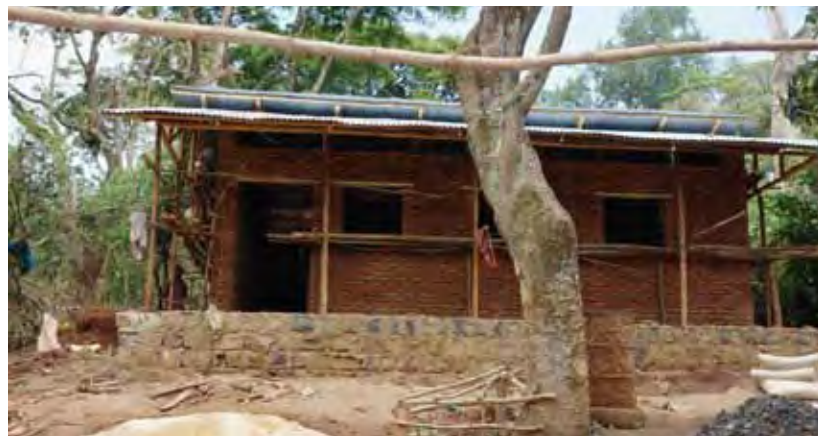
«Honeyhouse» im Rohbau
