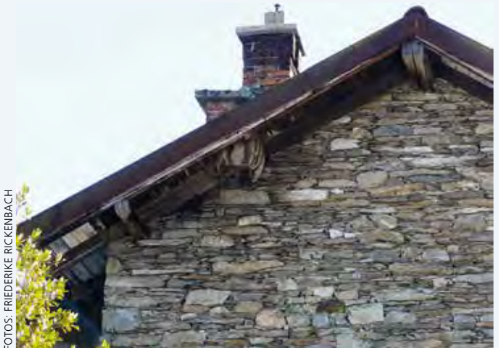
Auf der Höhe des Kamins ist unter dem Dachvorsprung der Wabenbau eines Bienenestes zu erkennen.
