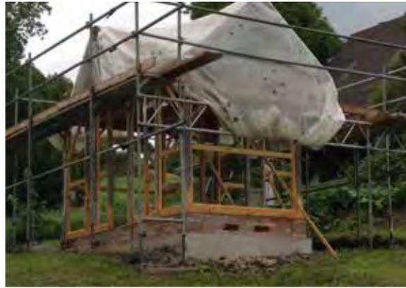
Das Fundament musste erneuert und das morsche Holzwerk im Sockelbereich ersetzt werden. Für die Bauarbeiten stützte ein beidseitiges Stahlgerüst das Giebeldach ab (links). Am 23.8.2017 konnte ein Aufrichtebäumchen aufs Dach gesetzt und mit den Besitzern auf die Renovation angestossen werden (rechts).
