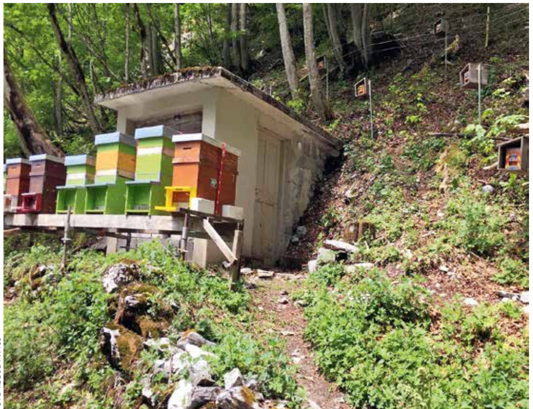
Der unterste Drohnenvolkstand (Standnummer 78 1505). Das 1973 erbaute Bienenhaus musste lawinensicher sein, darum entschieden die damaligen Züchter das Bienenhaus zu betonieren. Heute verstauen wir darin einen Teil des Materials.
