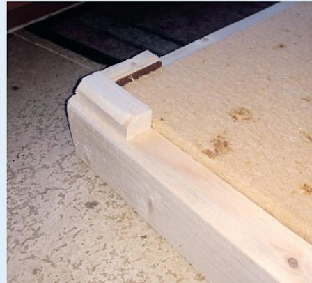
**Links:** Hinterlüfteter Deckel und **rechts** Abstandshalter an den Ecken für den hinterlüfteten Blechdeckel.
